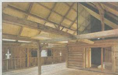
Nekdanji senik je razdeljen na zastekljeni in neizolirani del.
