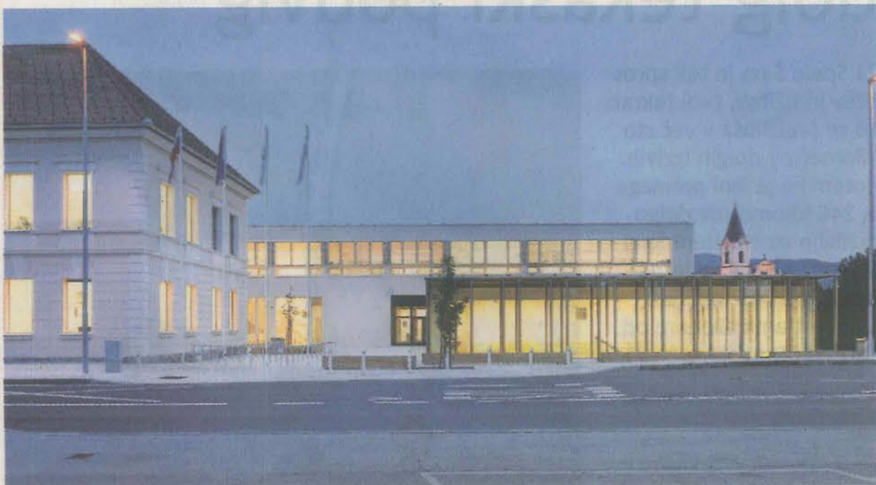
Obstoječa šola z novo šolsko stavbo in telovadnico © Miran Kambič
