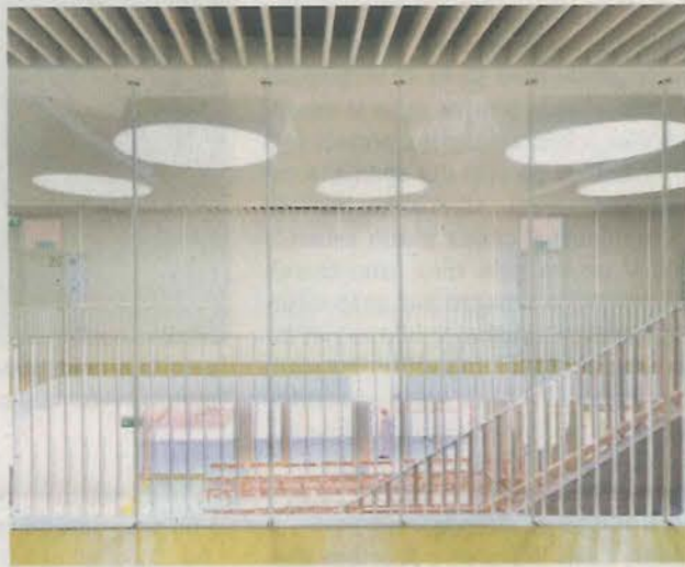
Naravna osvetlitev dvovišinskega prostora šole
